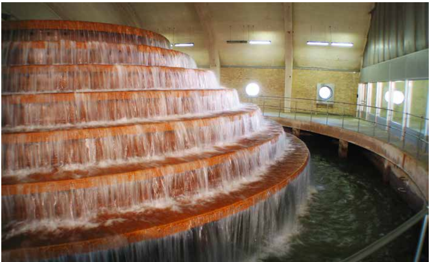
Simpel vandbehandling på et dansk vandværk.
